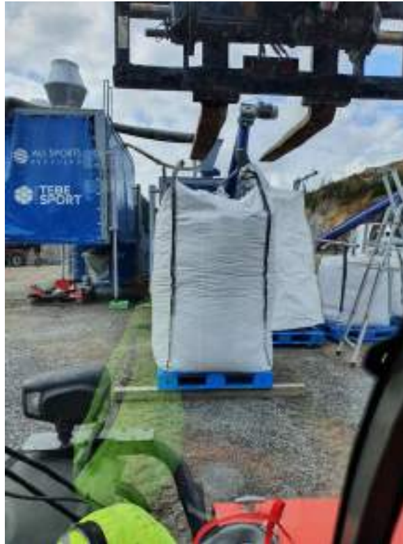
Sand og SBR/TPE/EPDM fjernes, renses, tørkes og plasseres i big-bags, klargjort for gjenbruk
